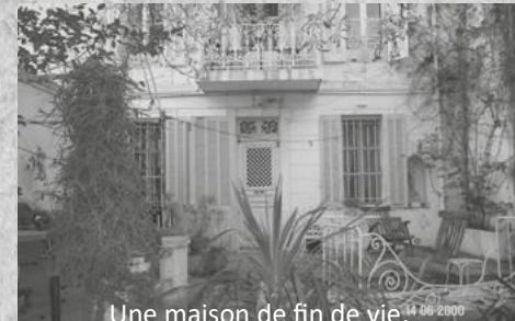
Une maison de fin de vie, d'indécence....
